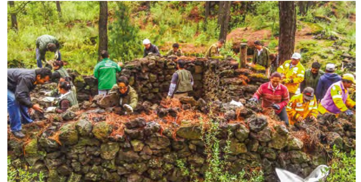
Trabajos para inhibir la construcción de viviendas en la región de Ajusco Medio, 28 de noviembre de 2016.
