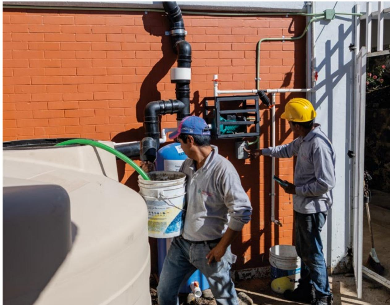
El llenado del almacenamiento secundario se realizará de forma manual, es decir, se requiere prender y apagar manualmente la bomba mediante el interruptor termomagnético que se instala junto con el SCALL
