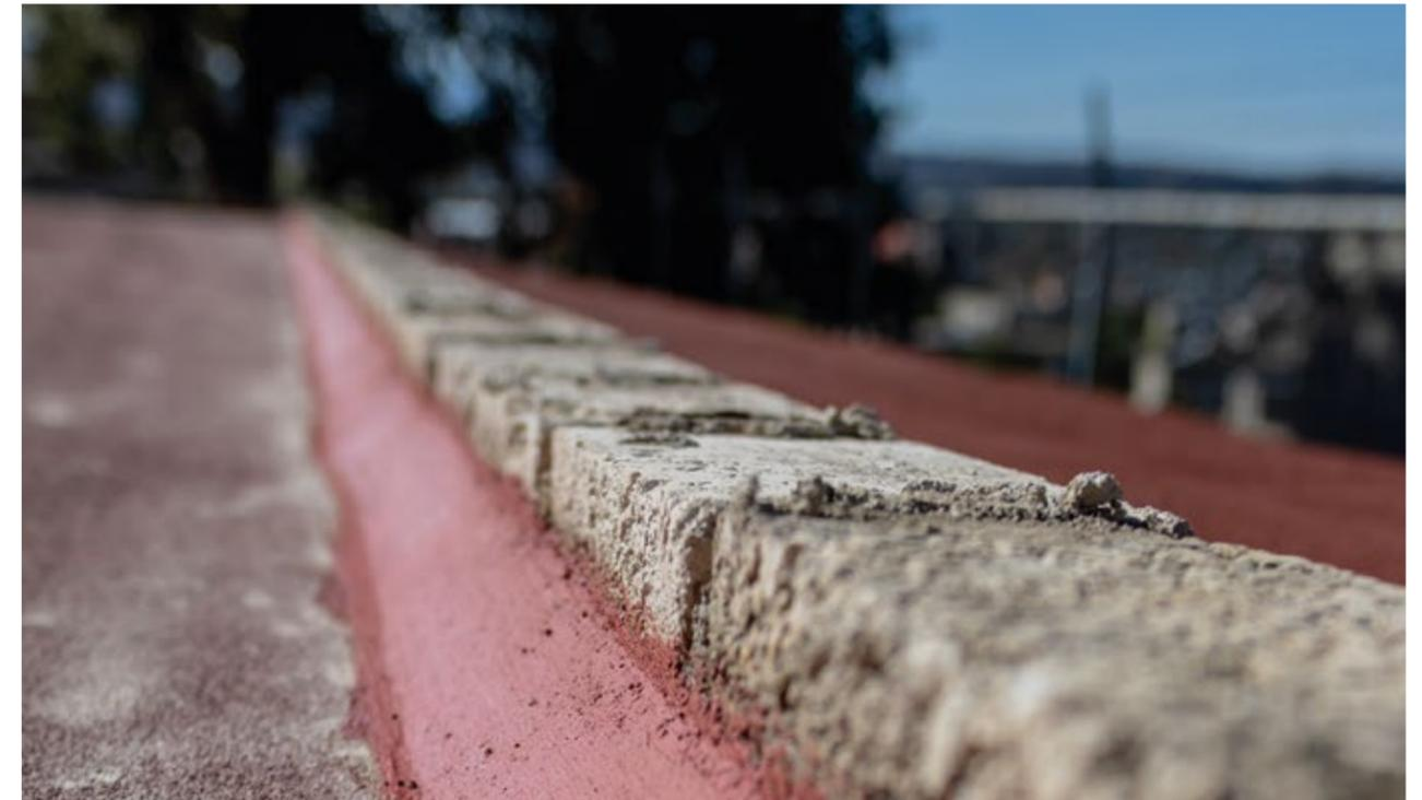
El junteo del pretil deberá estar bien sellado y no permitir que el agua de lluvia se trasmite a través del pretil. Se colocará un chaflán cubierto con una capa de impermeabilizante para evitar filtraciones de agua
