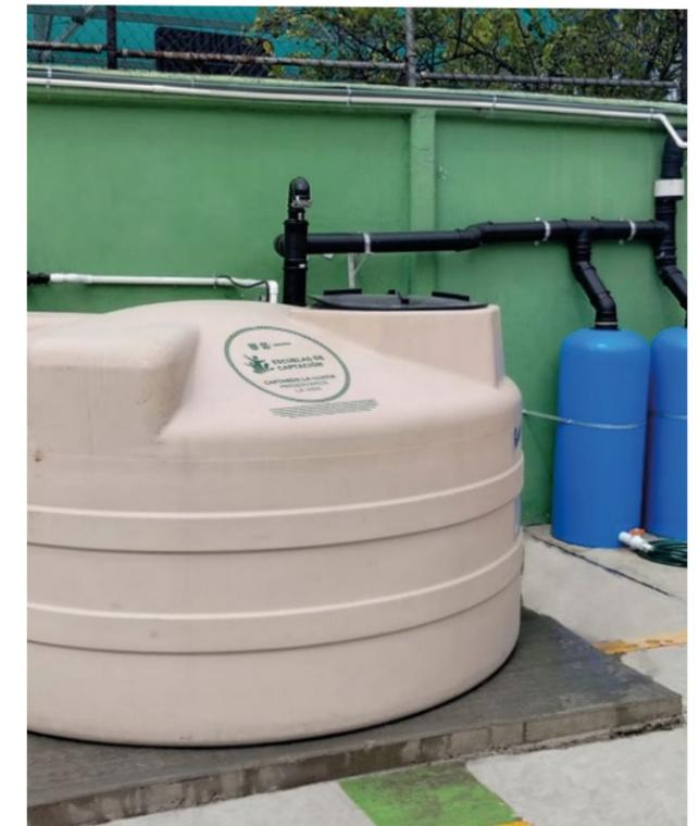
La cisterna se colocará una vez que la base de concreto haya secado o por lo menos 24 horas después de su colocación, previa realización del curado del concreto
