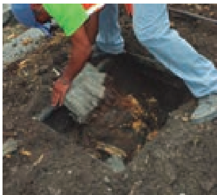
Figura 4.14 Extracción de tocones de forma manual, para realizar la sustitución con otras especies arbóreas.
