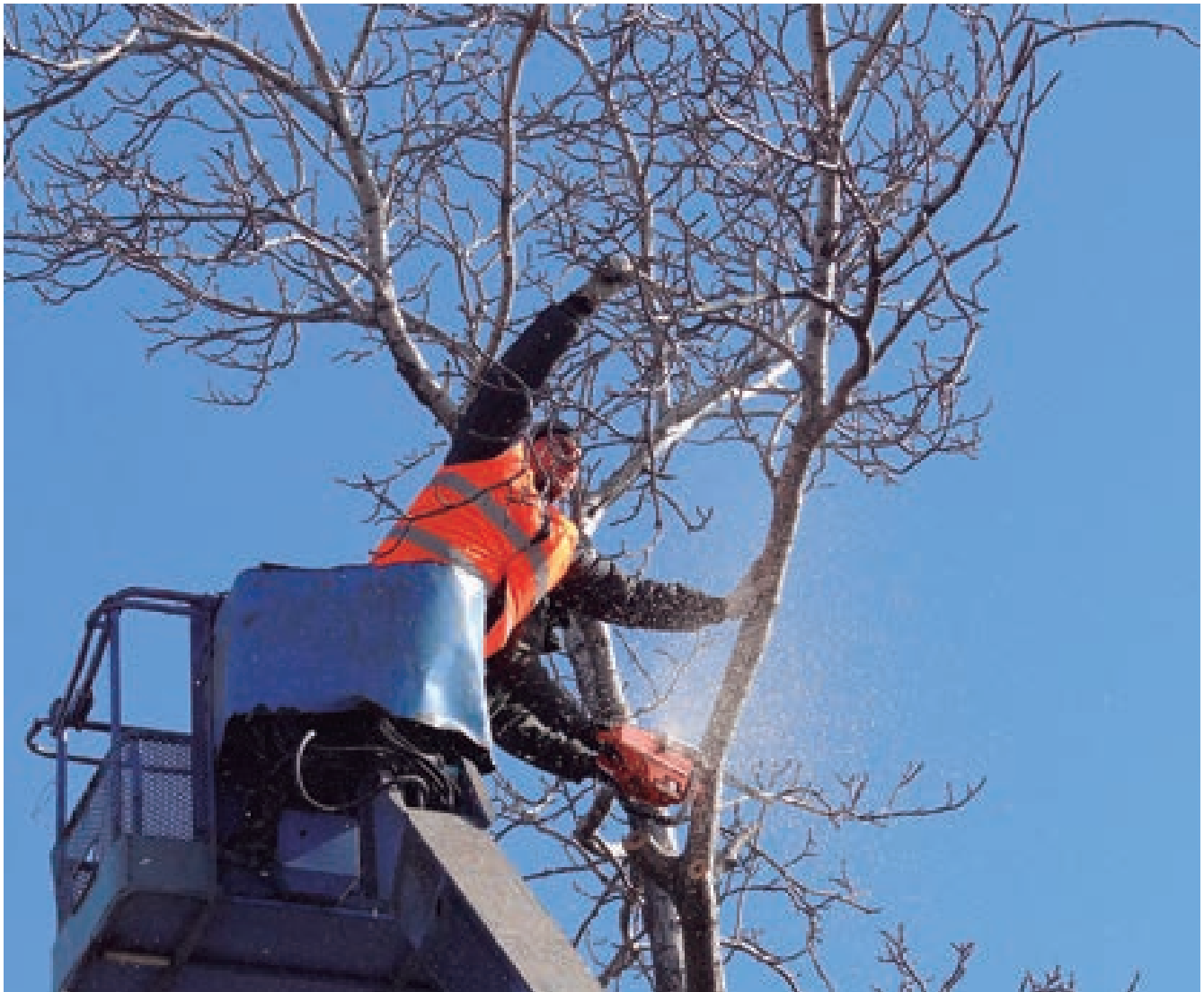
Figura 3.11 Utilización de canastilla para trabajos de poda en árboles, liberando equipamiento urbano e infraestructura aérea.
