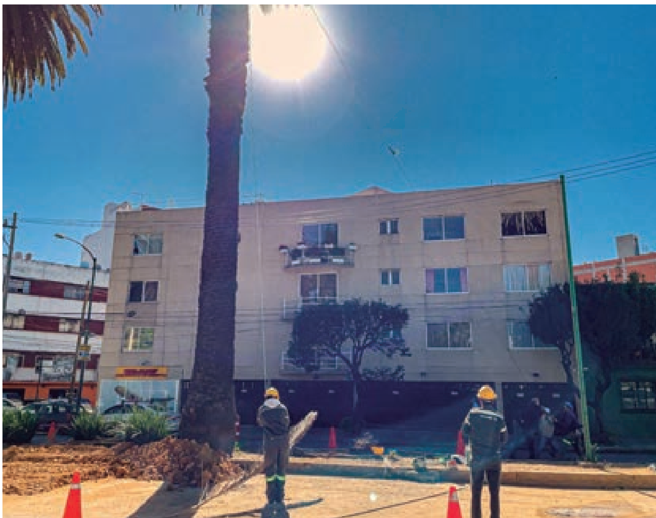
Figura 4.8 Señalización previa a los trabajos de poda.
