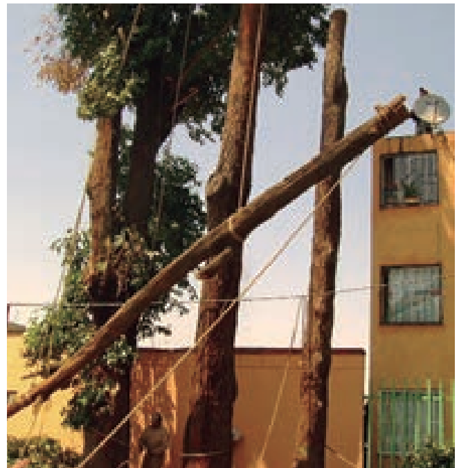
Figura 4.10 Derribo controlado.
