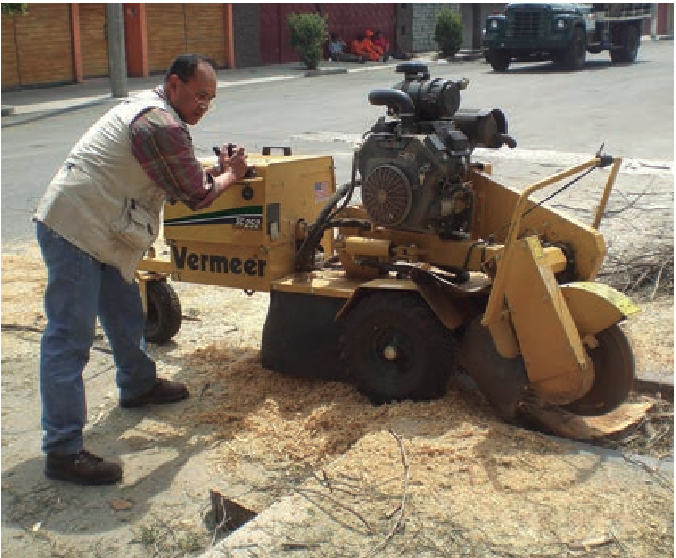
Figura 4.15 Destoconadora mecánica, devastando tocones de árboles derribados en banqueta y espacio abierto.
