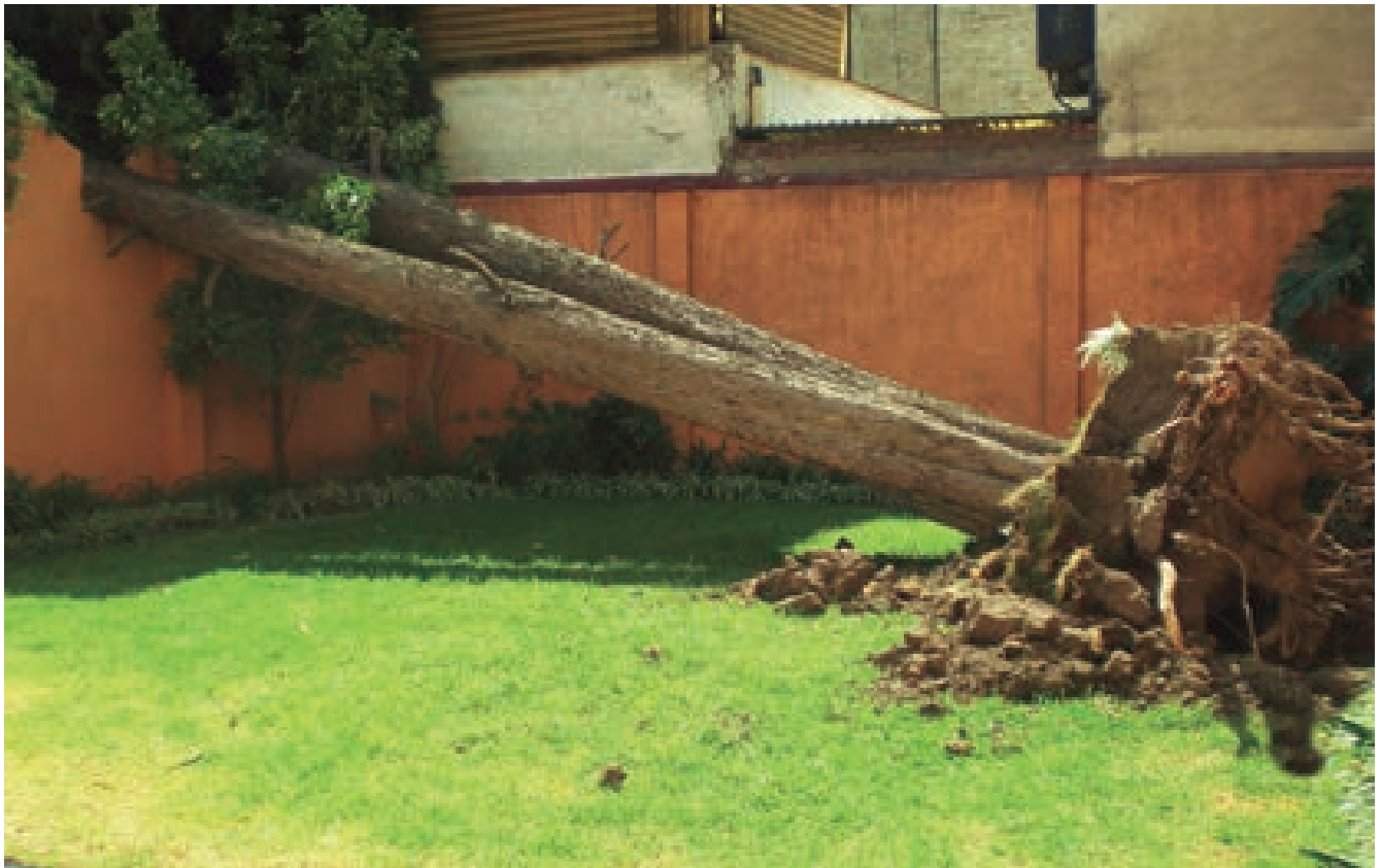
Figura 4.3 Cedro blanco ( Callitropsis lusitanica ) desplomado sobre muro colindante con otro inmueble.
