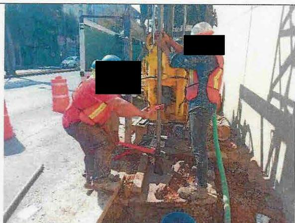
**Foto No. 1.8** Exploración y muestreo del sondeo mecánico directo S-5A
