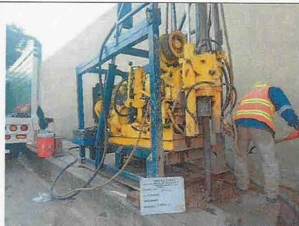
**Foto No. 1.7** Instalación del equipo de perforación en el punto del sondeo S-5A.
