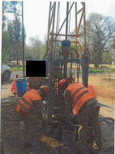
Fotografía 3. Avance de perforación T-33 (SPT-1).
