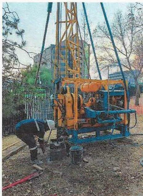
Fotografías 1 y 2. Posicionamiento del equipo y ejecución del sondeo, SPT-1, T-30.
