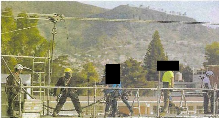
Trabajo de acortamiento de cable
