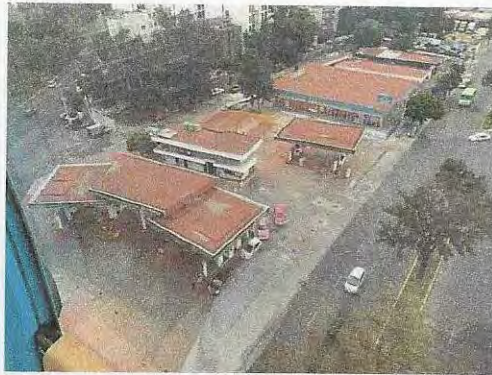
Zonas críticas con riesgo de incendio
