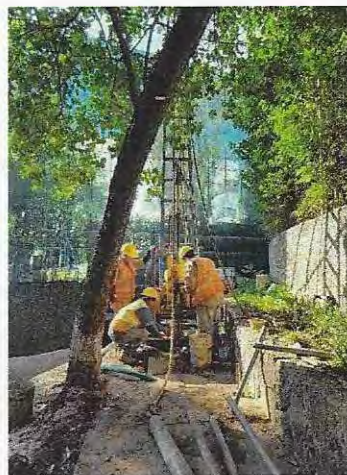
Fotografía 2. Exploración y muestreo del sondeo SPT-1
