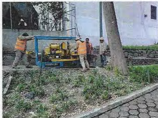
Fotografía 6. Reacondicionamiento del área retiro de herramienta y equipo del sitio.
