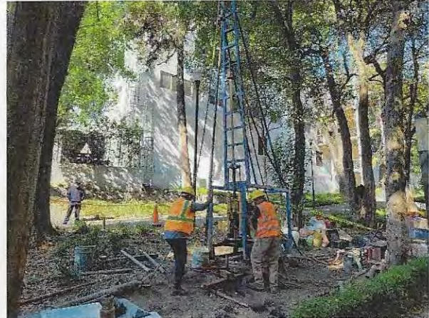
Fotografía 8. Exploración y muestreo del sondeo mecánico directo SPT-2.
