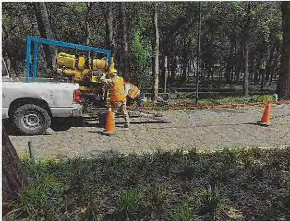
Fotografía 7. Preparación para Instalación del equipo de perforación en el punto del sondeo SPT-2.
