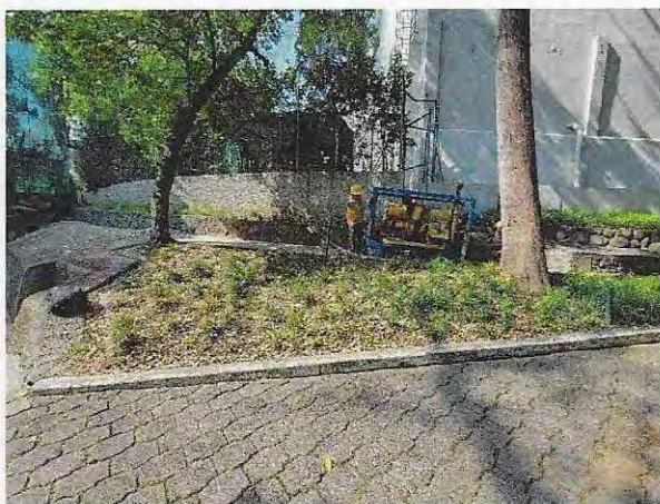
Fotografía 1. Preparación para Instalación del equipo de perforación en el punto del sondeo SPT-1.
