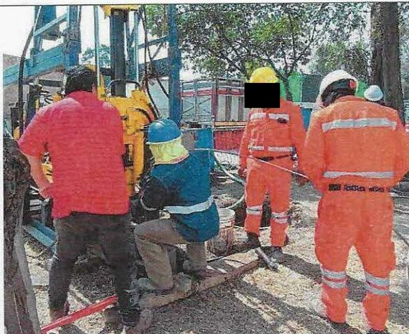
**Foto No. 1.8 Exploración del subsuelo con el sondeo mecánico directo SAC-13A**
