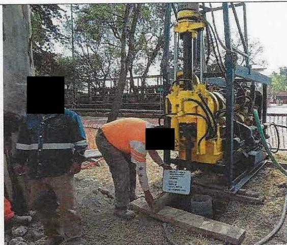
**Foto No. 1.7 Instalación del equipo de perforación en el punto del sondeo SAC-13A.**
