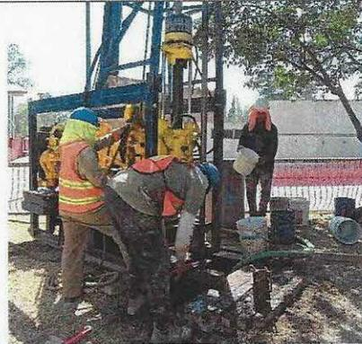
Foto No. 1.2 Exploración y muestreo del sondeo mecánico directo SPT-13
