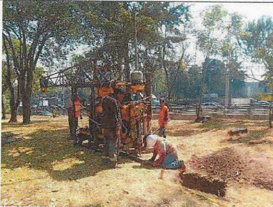
Foto No. 1.1 Arribo al sitio e instalación del equipo de perforación en el punto del sondeo SPT-11.
