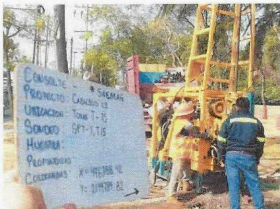
Fotografía 3. Ejecución del sondeo SPT-01
