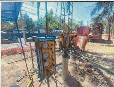
Figura 1. Vista panorámica del sitio.
