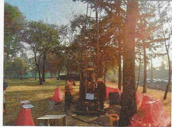
Foto No. 1.2 Exploración y muestreo del sondeo mecánico directo SPT-11
