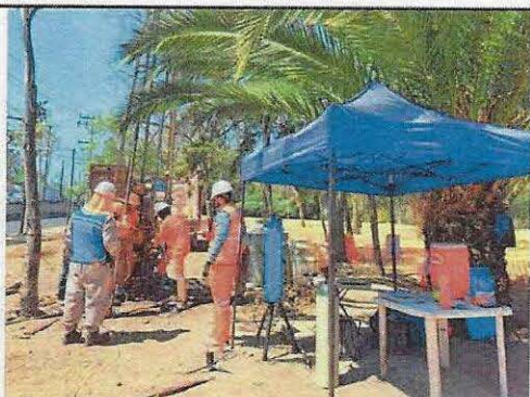
Figura 1. Vista panorámica del sitio.
