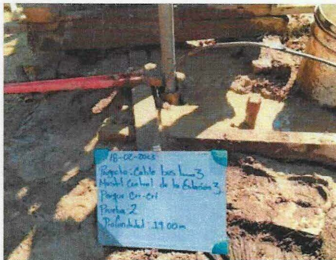
Foto 2.- Ejecución de prueba de presiometro de 19.0m de profundidad.
