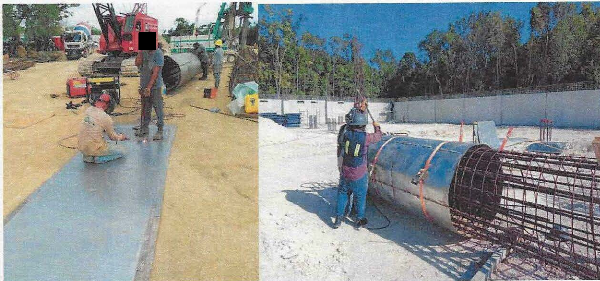
Fotos 1 y 2. Encamisado de lámina para formar ademe perdible.
