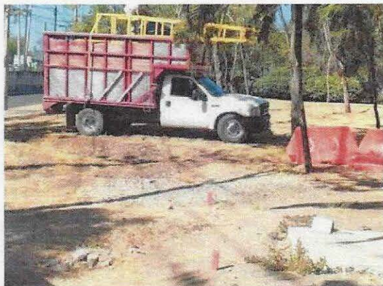
Fotografía 1. Posicionamiento de maquinaria para ejecución de sondeo de penetración estándar (SPT).
