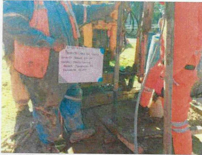
Foto 3.- Ejecución de prueba de presiometro de 26.0m de profundidad.
