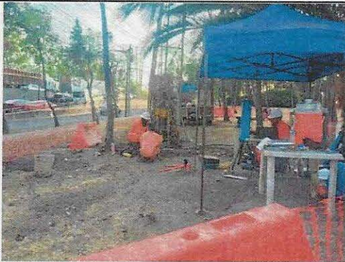
Figura 1. Vista panorámica del sitio.
