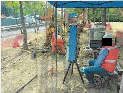
Figura 1. Vista panorámica del sitio.
