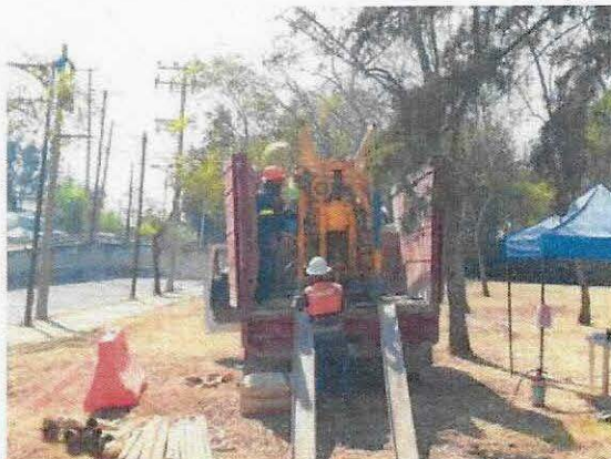
Fotografía 2. Posicionamiento de maquinaria para ejecución de sondeo SPT.
