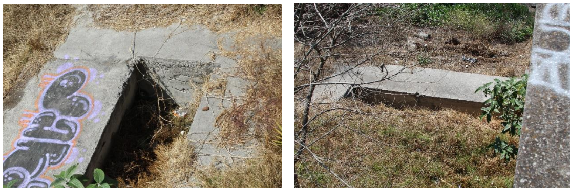
Figura 2.10 Vertedor de la presa Dolores.
