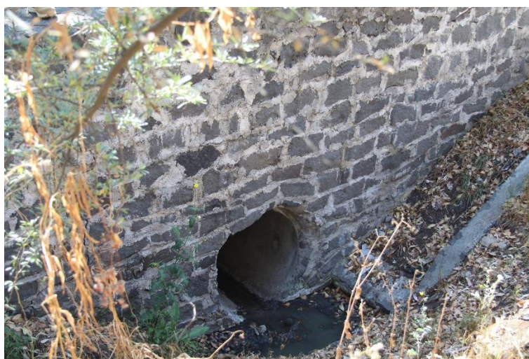
Figura 2.5 Alcantarilla que cruza la avenida y capta el agua de las casas.
