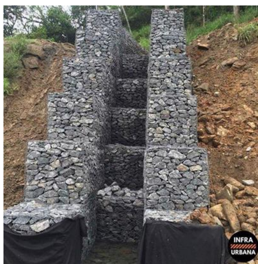
Figura 5.3. Arreglo de un gavión lateral.
