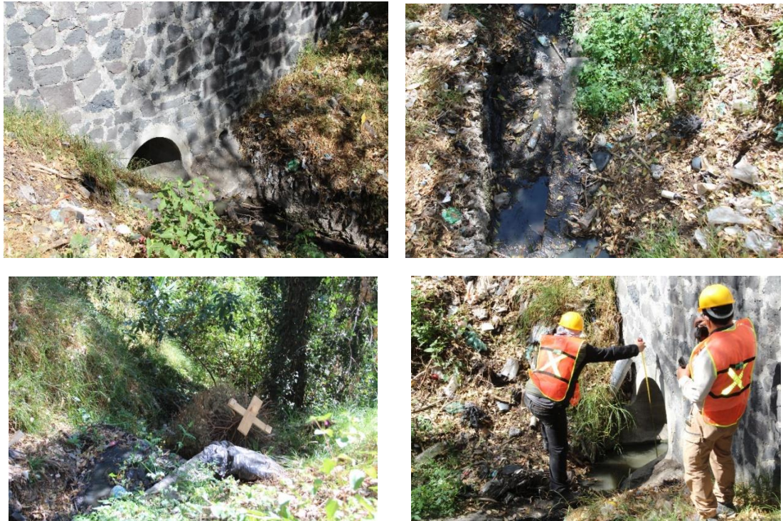
Figura 2.6 Salida y caída a la barranca.
