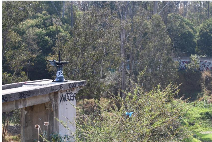
Figura 2.8 Manivela de compuerta de la obra de toma.
