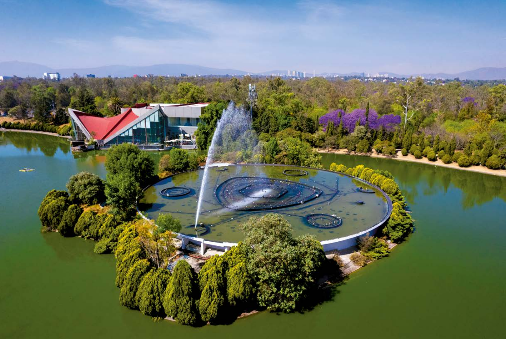
Fuente Monumental del Lago Mayor, después de rehabilitación.
