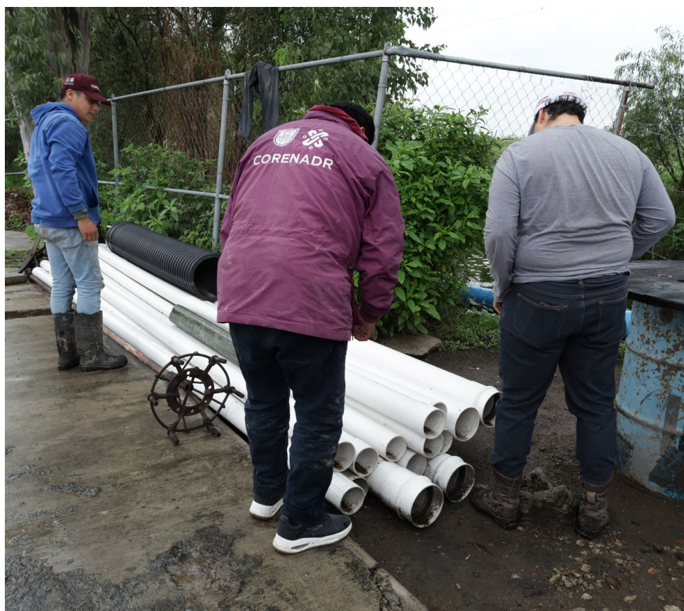
.Mantenimiento a equipos de bombeo y líneas de conducción de agua tratada. Retiro, mantenimiento y reinstalación del equipo de bombeo y líneas de conducción. San José. Tláhuac, 2025. Foto: DGCORENADR
